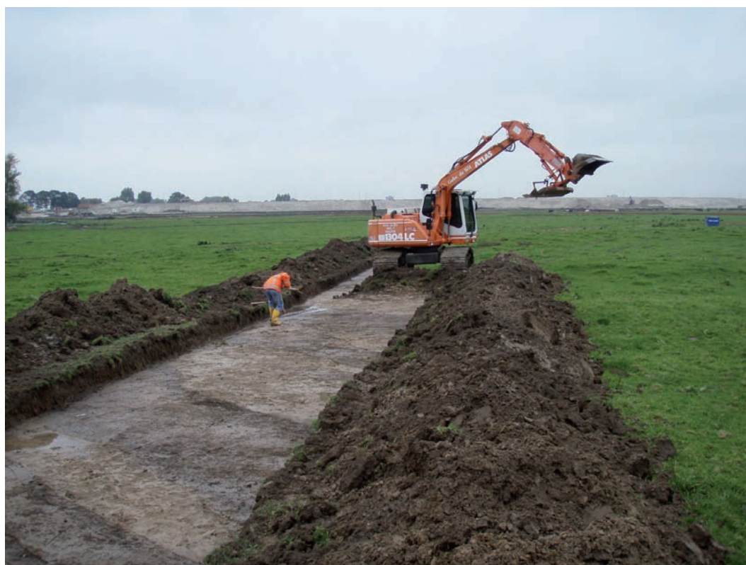
Afb. 12 Aanleg van één van de proefsleuven tijdens het vooronderzoek.
